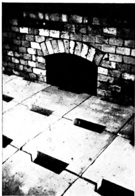
Rusztwa szamotowe w komorze wypalowej pieca.
