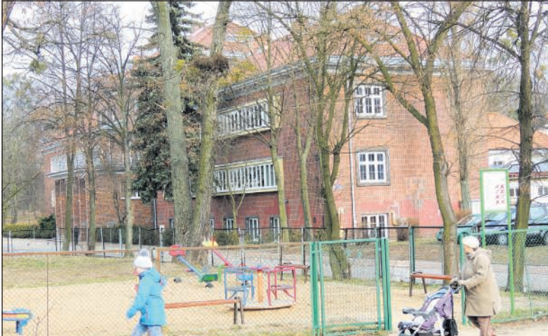
Jeden z budynków zajmowanych przez ZS nr 14. Kiedyś mieściło się tutaj III Liceum Ogólnokształcące
