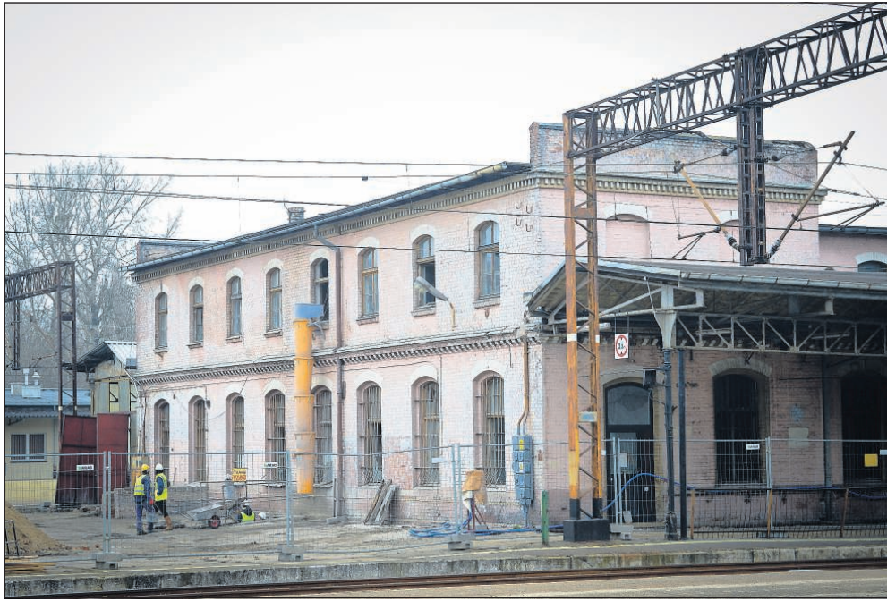
Rozpoczął się już remont budynku dawnej poczty. Lada moment obok przystanku autobusowego przy ulicy Podgórskiej rozpocznie się też kopanie przejścia podziemnego.
