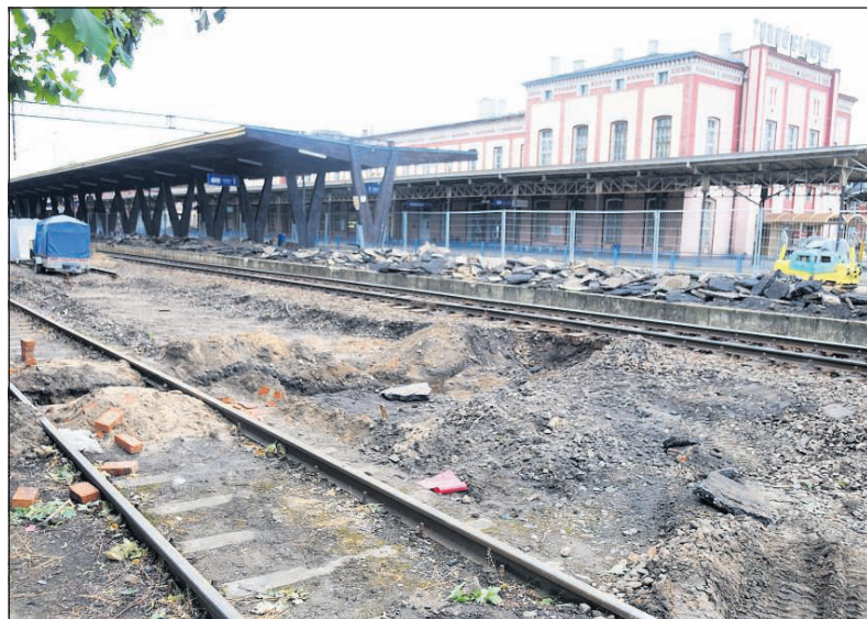
Ekipy pracujące przy renowacji toruńskiego Dworca Głównego przygotowują się do budowy tunelu pod torami FOT.: GRZEGORZ OLKOWSKI
